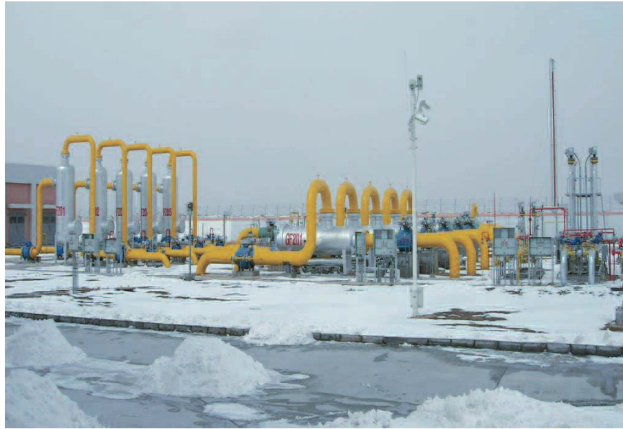
ウエップのガスパイプライン・プロジェクト：中国
